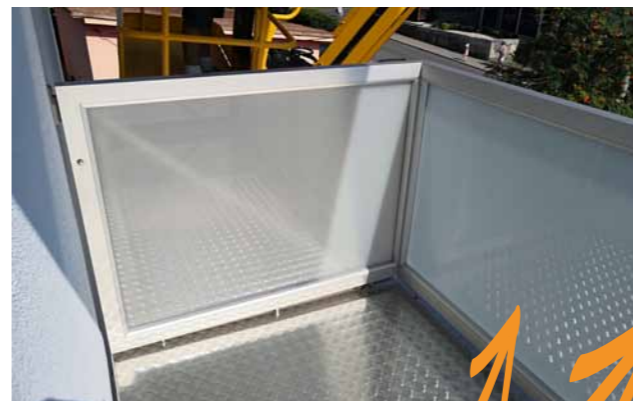
RAILOG® zavěšené balkóny Čadca - Slovensko
